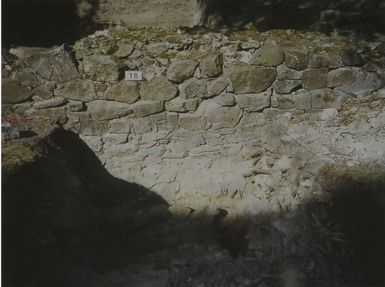
Ryc.2. Giecz—Grodziszczko, stan. 1. Wykop 2—lico północne fundamentów kościoła · grodowego
