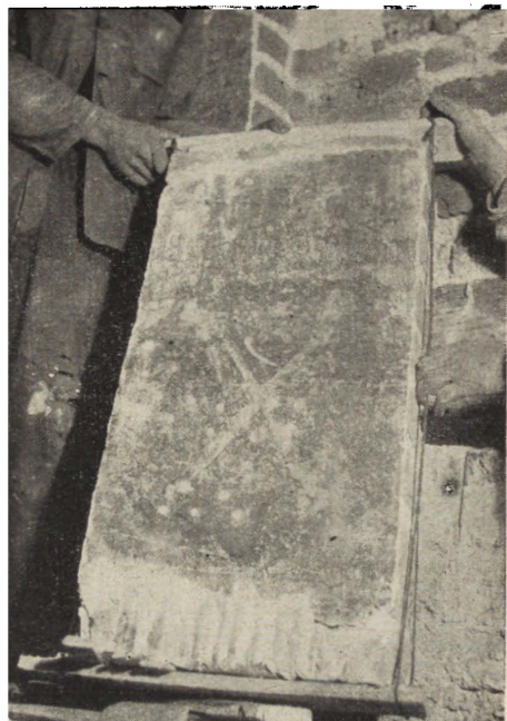
Ryc. 118. Odcięta płyta ustawiona na rusztowaniu. (Fot. K. Dąbrowski).
