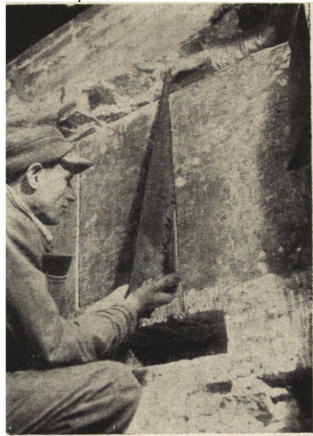
Ryc. 116. Odcinanie równoległe ze ścianą, od tyłu. (Fot. K. Dąbrowski).
