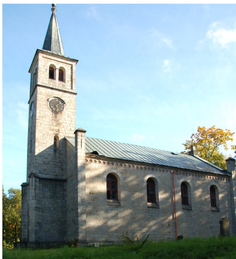
Ryc. 3. Kościół ewangelicko- reformowany w Pstrążnej koło Kudowy Zdroju
