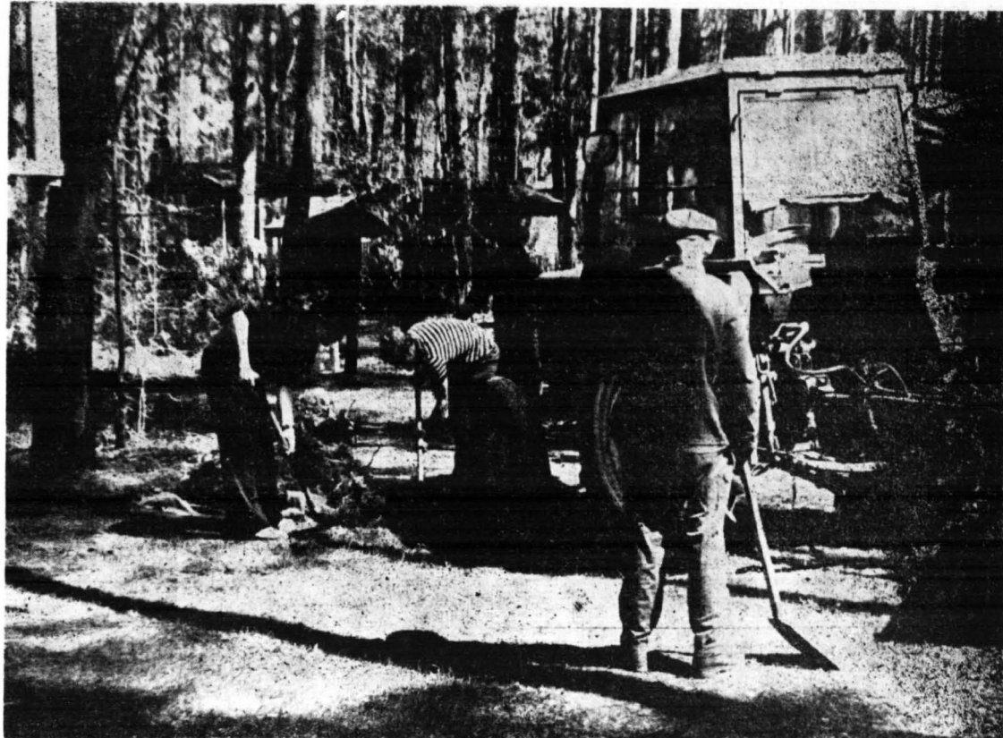
Wiele prac malarsko-budowlanych w ośrodku wczasowym w Soczewce pracownicy FMZ wykonali samodzielnie. Na zdjęciu grupa pracowników Fabryki podczas wykonywania prac porządkowych na terenie ośrodka
