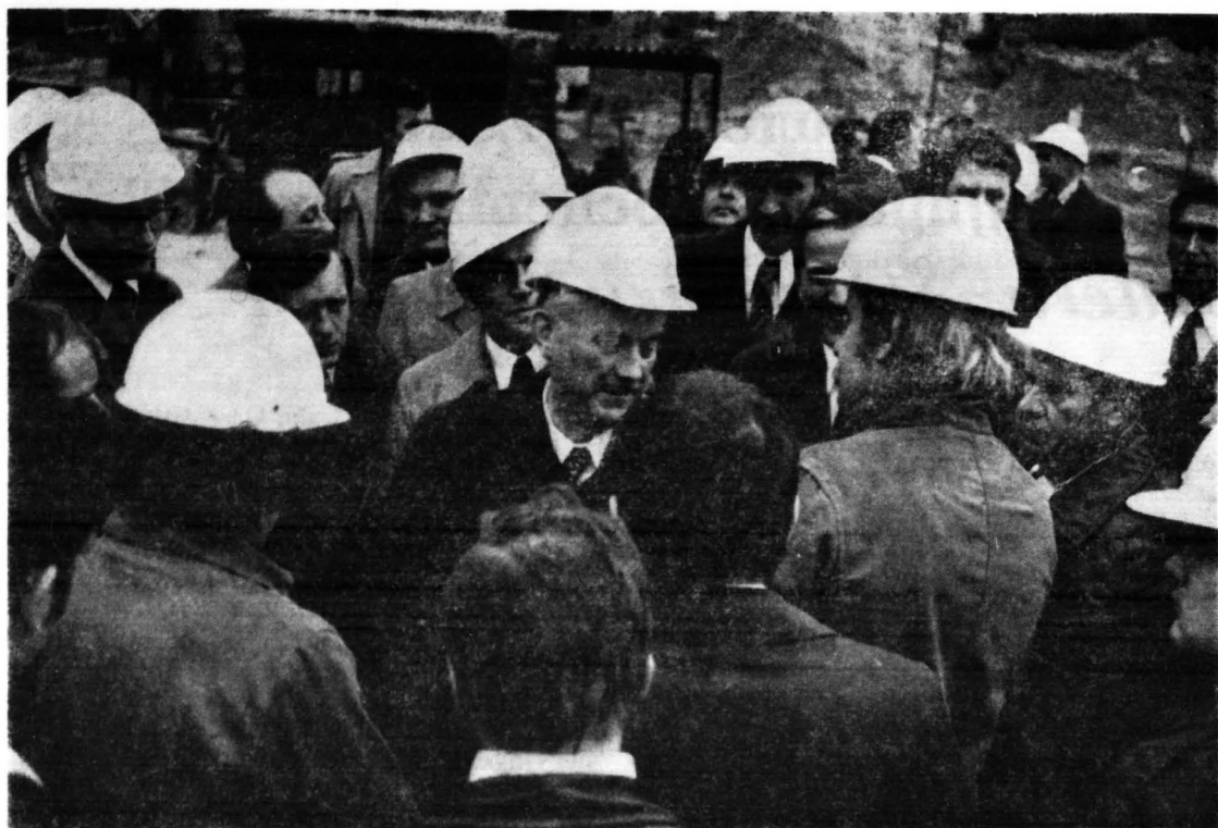
Prezes Rady Ministrów Piotr Jaroszewicz w rozmowie z budowlanymi na budowie Wytwórni Olefin II, które w obecnej 5-latce (1976—1980), są największą inwestycją polskiej chemii (nakłady około 20 mld zł). Ich miał na myśli Premier mówiąc na uroczystości: „Jak każdej silnej dywizji, tak i Wasi towarzyszy mocna brгада saperów. Są nią Wasi budowlani. Po 2 latach trudno dziś poznać ten zakład. Toteż pamiętajcie, że jakiś promień, który otacza przekazany Wam Sztandar Pracy I Klasy, należy się budowlanym”.
