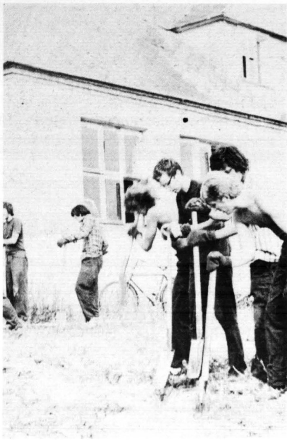
Stacja Terenowa w Murzynowie — studenci przy pracach remontowych
