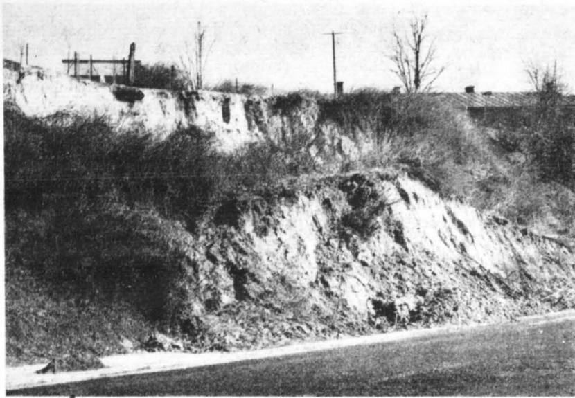
Świeży obryw przy ZOO płockim.
