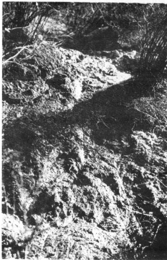
Erozja powierzchniowa krawędzi nadwiślańskiej. Woda opadowa i roztopowa płynąc po zboczu dzięki sile ciężkości wypłukuje (niszczy) unoszą (transportuje) i osadza (akumuluje) drobne cząstki skał luźnych, zwietrzeliwy i gleby. Ten proces sputkiwania postępuje albo powierzchniowo, gdy woda płynie warstwą po stoku, lub większą ilością drobnych, nieciągłych nitek wodnych i cały stok — niszczy równomiernie albo liniźnie, gdy woda spływająca po stoku dzieli się na ciągłe nitki i strugi, a proces niszczenia ograniczany jest do bruzd, którymi woda spływa.
