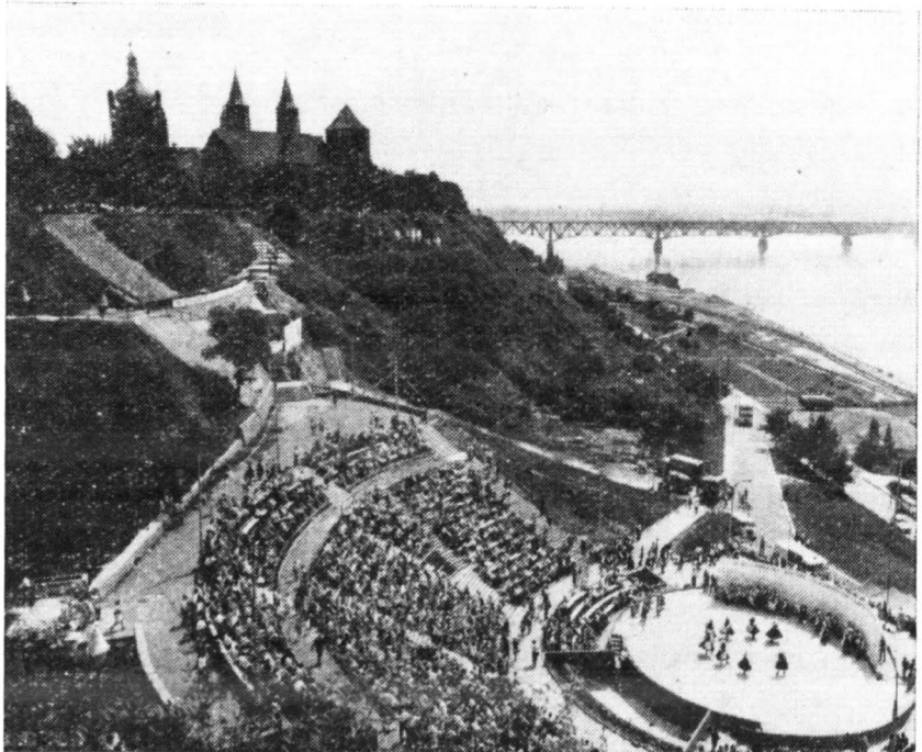
Amfiteatr wraz ze schodami (wyjścia na skarpe) — to najważniejszy czyn w dziale „Kultura”. Współdziałało przy jego budowie wiele zakładów i osób. Największy wkład dała załoga Płockiego Przedsiębiorstwa Robót Mostowych. Projektant główny — inż. Czesław Korgul, kierownik budowy — mgr inż. Zygmunt Pater.
