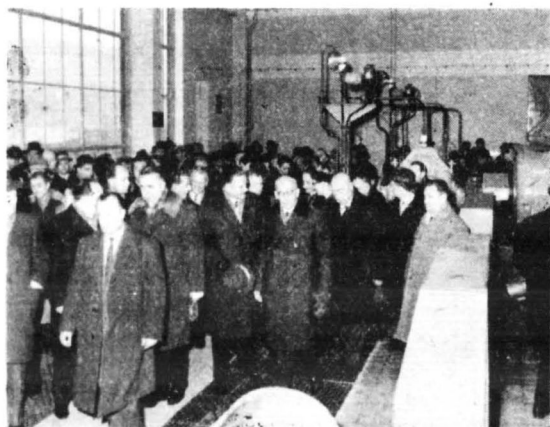
Zwiedzanie wraz z delegacjami zagranicznymi przepompowni ropy.
