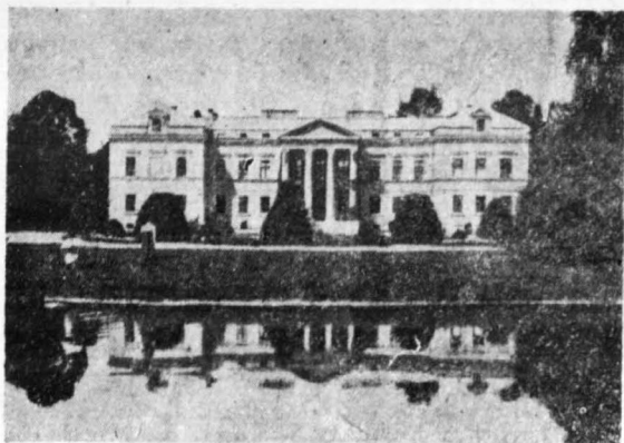
Pałac w Skrwilnie zniszczony podczas ostatniej wojny
