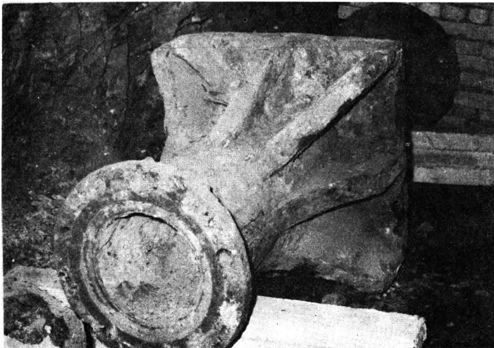
Ryc. 6. Kształtka podporowa rurociągu parowego
