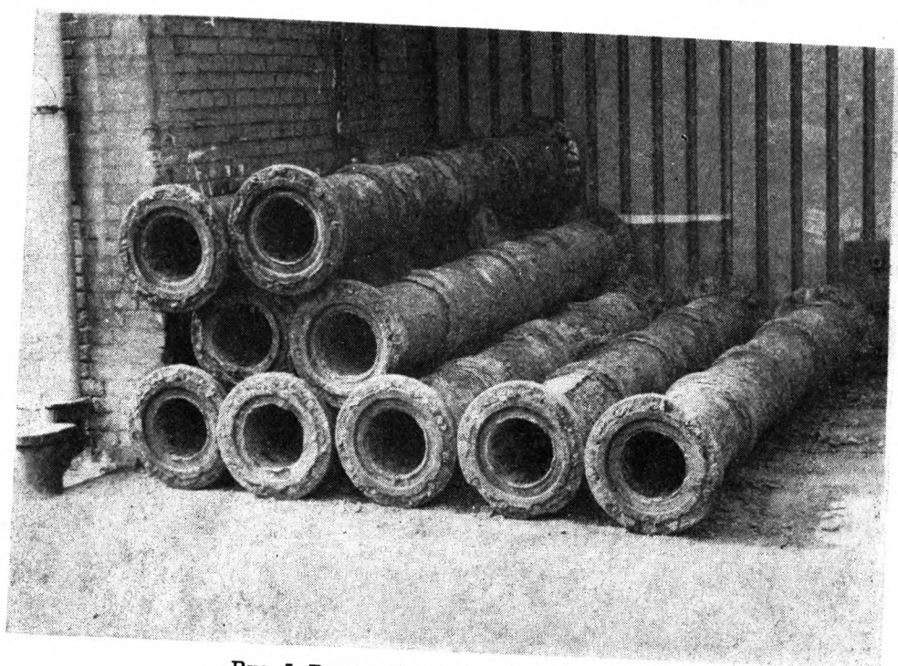
Ryc. 5. Rury żeliwne rurociągu parowego
