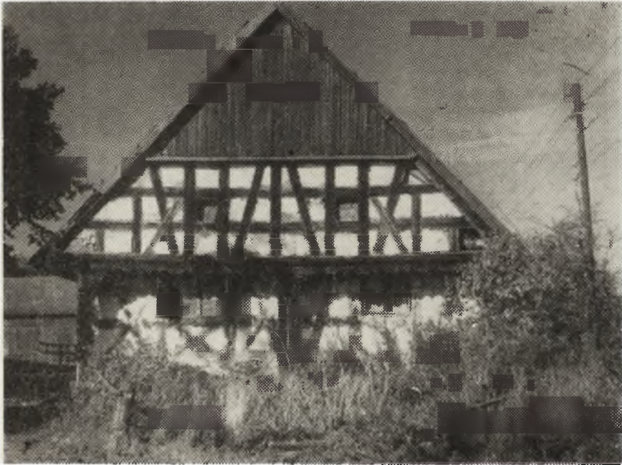
Ryc. 10. Chałupa podcieniowa ze szczytem na „mur pruski”. Muławki, pow. kętrzyński.
