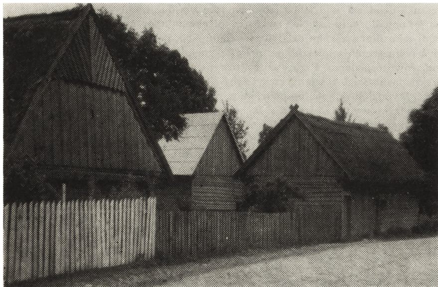
Ryc. 14. Zagroda z bramą wjazdową na podwórze, po przeprowadzonej konserwacji w r. 1958. Krzyżewo, pow. elcki.
