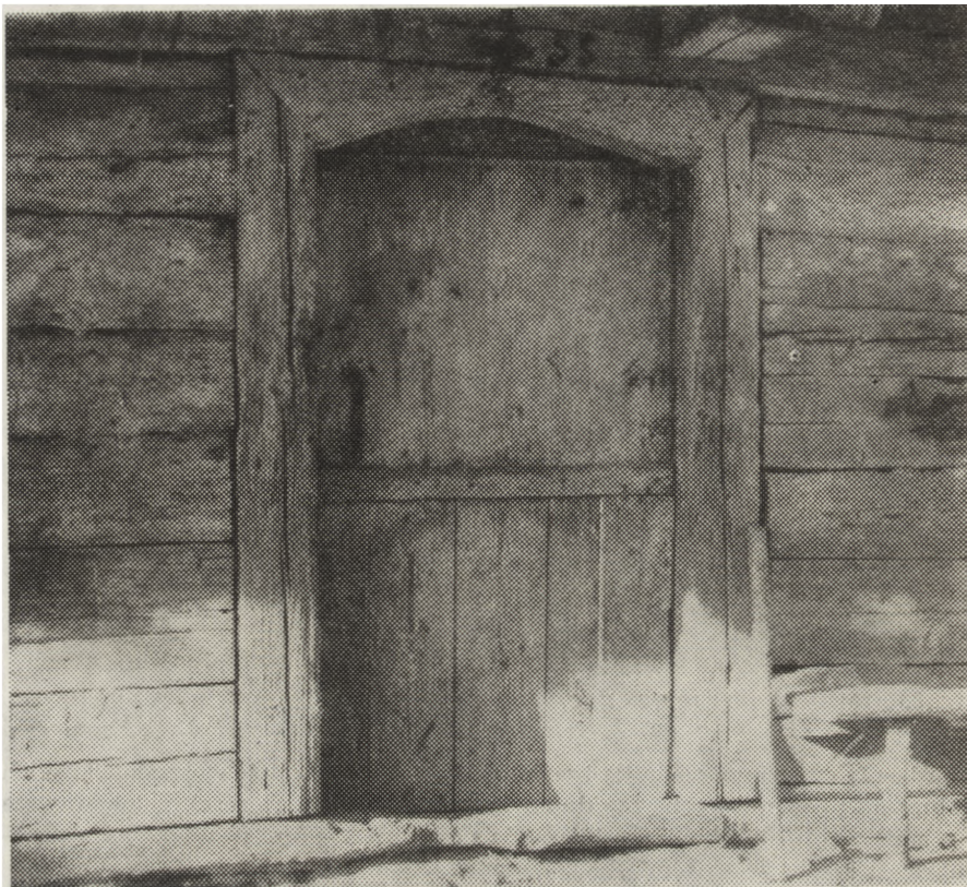
Ryc. 9. Dwudzielne drzwi wejściowe do chałupy. Nowa Różanka, pow. kętrzyński.
