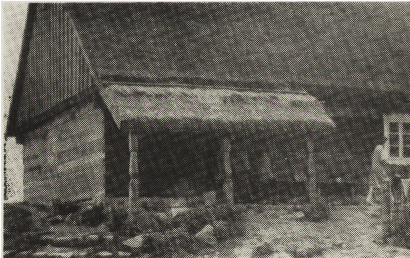
Ryc. 13. Chałupa z podcieniem wypustowym, po przeprowadzonej konserwacji w r. 1958 przez Woj. Konserw. Zabytków w Białymstoku. Krzyżewo, pow. elcki.
