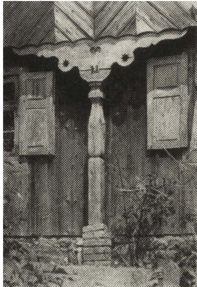
Ryc. 2. Środkowy słupek z chałupy podcieniowej, Klon, pow. szczycieński. Fot. F. Klonowski
