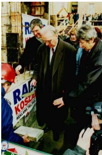
Ilustracja 10. Uroczystość wmurowania kamienia węgielnego pod nowoczesny obiekt Polskiego Radia w Koszalinie. Uczestnicy – od lewej: generalny wykonawca robót budowlanych PBO Piotr Flens, przewodniczący Krajowej Rady Radia i Telewizji Bolesław Sulik, Magdalena Kozień – projektant rozgłośni oraz prezes – redaktor naczelny PR Koszalin inż. Ryszard Zalewski
