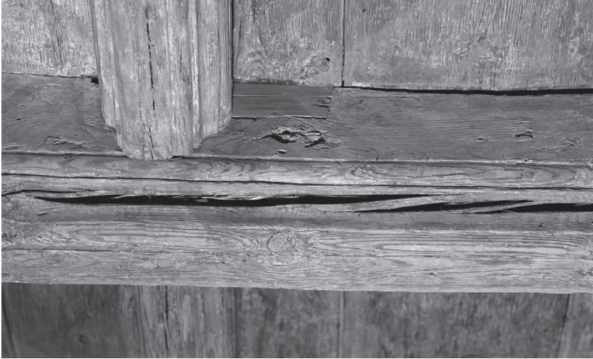
2. Strop na piętrze I od strony podwórza – fragment
