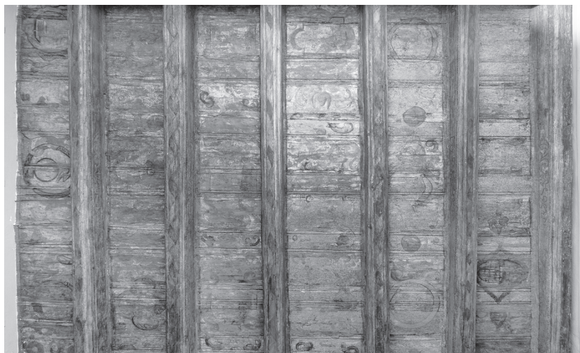
3. Strop na piętrze I od strony rynku – widok ogólny
