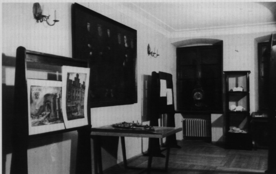
8. Sala wystawowa na pierwszym piętrze kamienicy Pod Murzynkiem, 1950 r.
